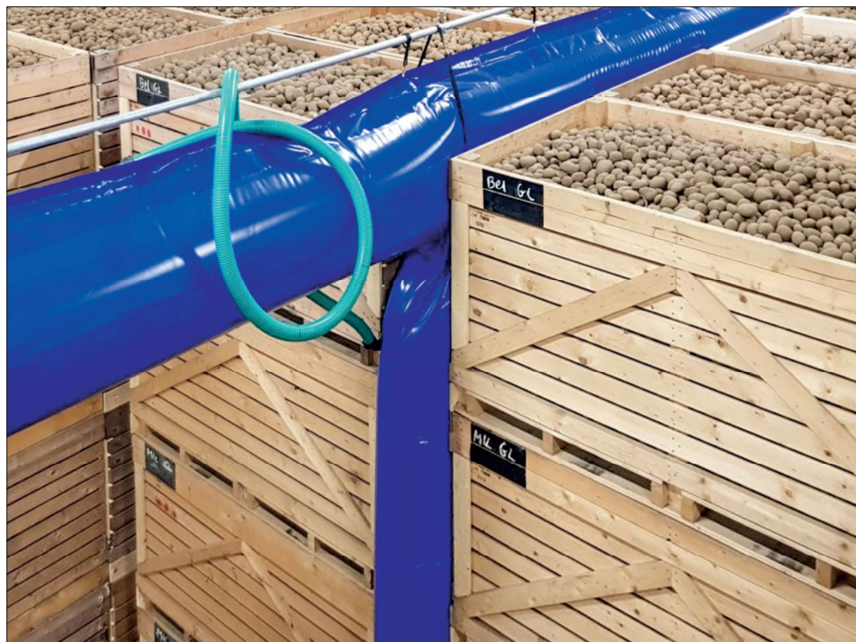
Obr. 13: Airbag systém tlakového větrání ohradových palet nizozemské firmy Mooij Agro
