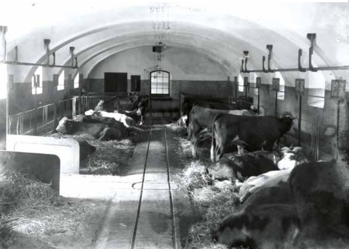
Interiér kravína Státní výzkumné stanice zemědělské v Libějovicích s visutou dráhou pro dopravu krmiva a hnoje, 1931. Sběrka Národního zemědělského muzea, inv. č. 5910.
